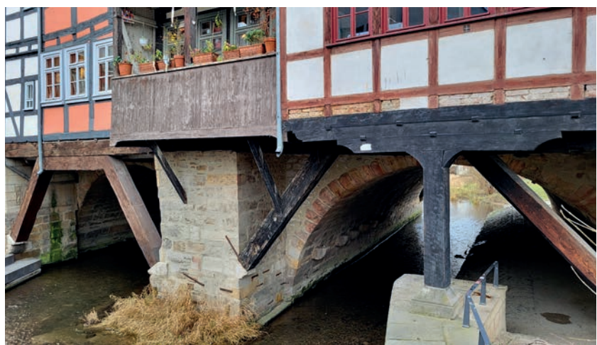
Bild 3: Pfeilervorlagen mit darauf abgesetzten Sprengwerken Foto: Hans-Jörg Vockrodt
