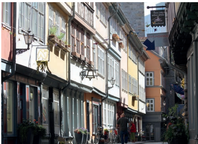
Bild 5: 1473/74 erbauter Fachwerk-Reihenhausbaublock mit Haus Nr. 11 – dem ältesten Haus auf der Krämerbrücke
