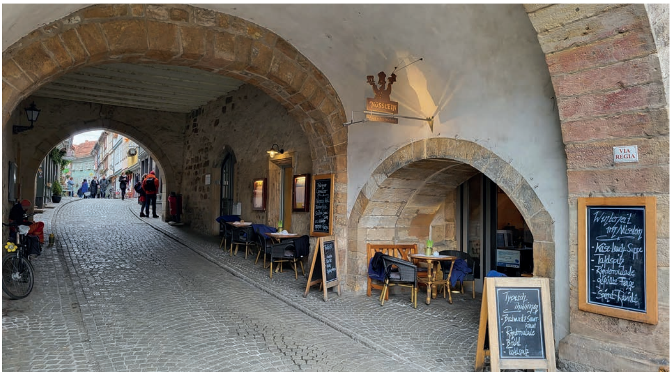
Bild 9: Tordurchfahrt unter der Ägidiuskirche mit Blick entlang der Brückengasse
